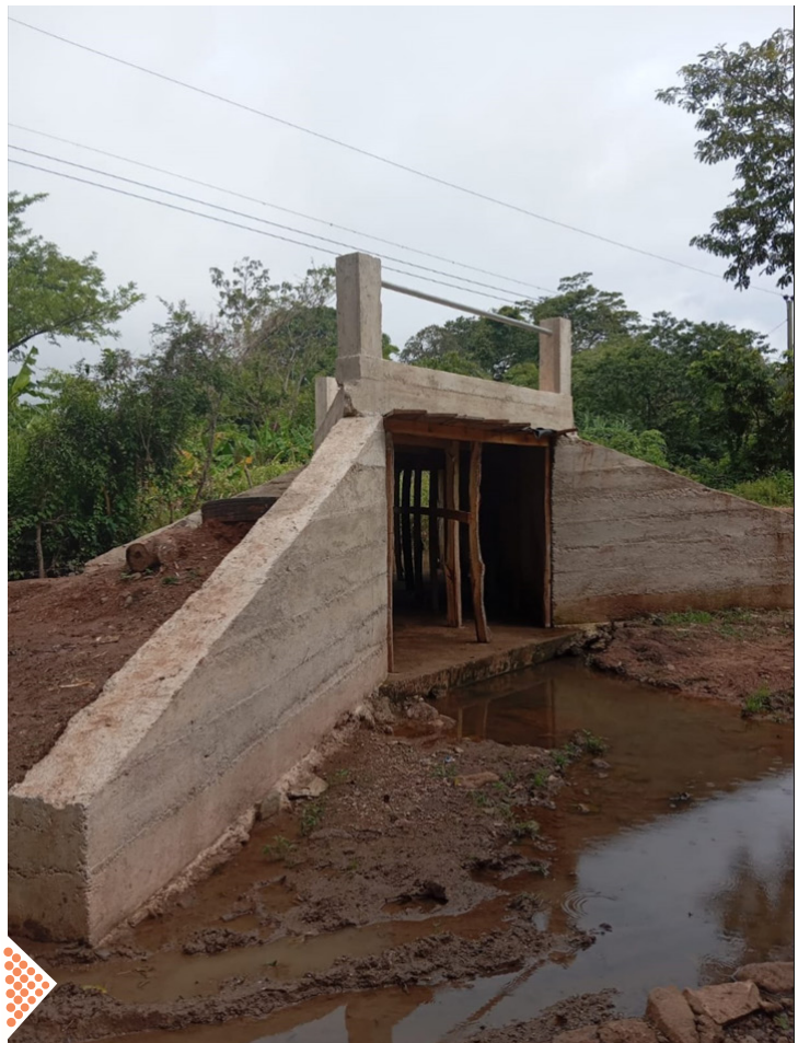
Avances de la construcción de la Caja Puente en la Comunidad El Destino, Marale.
