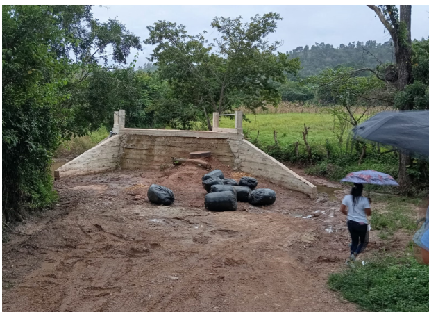
Avances de la construcción de la Caja Puente en la Comunidad El Destino, Marale.
